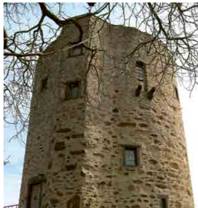
Scharfer Turm, Stadtbefestigung, als mittelalterliches Element
